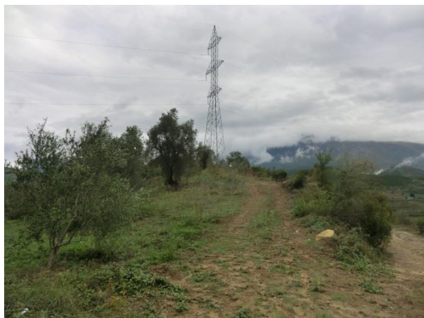
WPS120: Kullë elektrike në pikën kalimtare midis Gjurmës së Re të Gazsjellësit dhe gjurmës së rastit bazë (Mars 2014) – pamje V.
